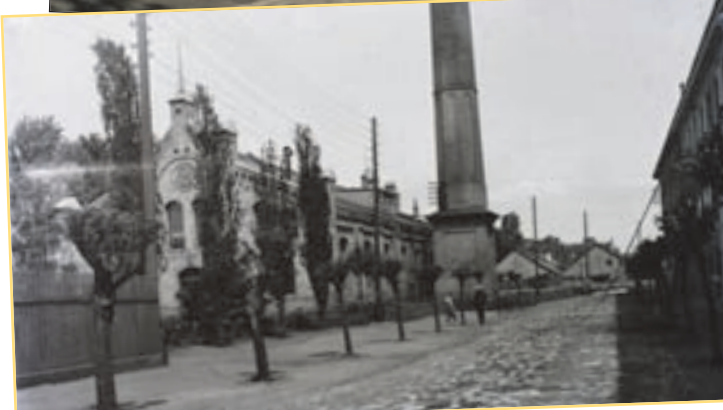
1927, Hajógyár utca, balra a hajógyári villamossági központ – korábban kazánház
