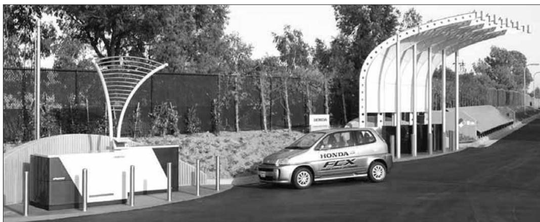
A Honda napfényes (jobbrol) és elektromos hidrogéntöltő állomása (balrol) tüzelőanyag-cellás gépkocsik számára
